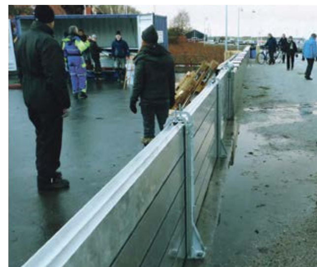
Januar 2019: Alu-plankerne er på plads og vandet kan bare komme an. Foto: Roskilde Kommune.
