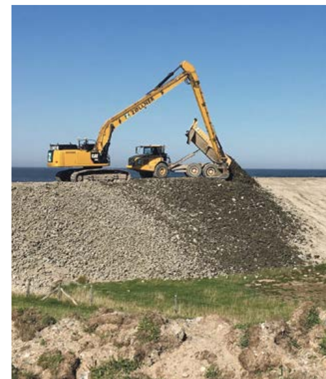
Et ekstra lag sten lægges på digerne på Sprogø.
