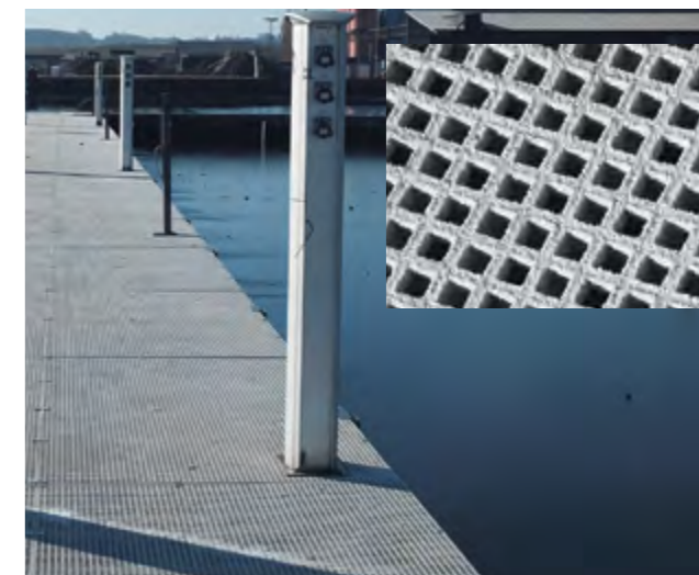
Til nye broer anbefales det at bruge Eurograte© finmaskede riste med sten i overfladen. Her ses et nyt brodæk i Horsens Marina.
