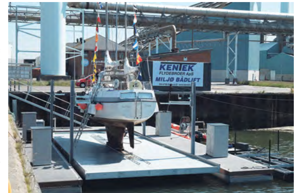
Ser man bådfliften bagfra, ses det tydeligt, at 'bradepanden' kan justeres, så vandet løber ned i opsamlarrenden og gennem brønden, videre til filtrering.
