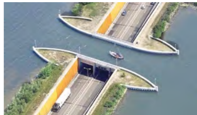
Illustrationerne viser, hvordan skibene kan sejle over vejen og der ved sikre en uhindret passage til Margretheholms Havn og Lynetten.
