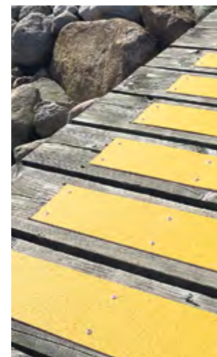
Materialet er en kun 3 mm tyk fiberplade med indstøbt sten.
