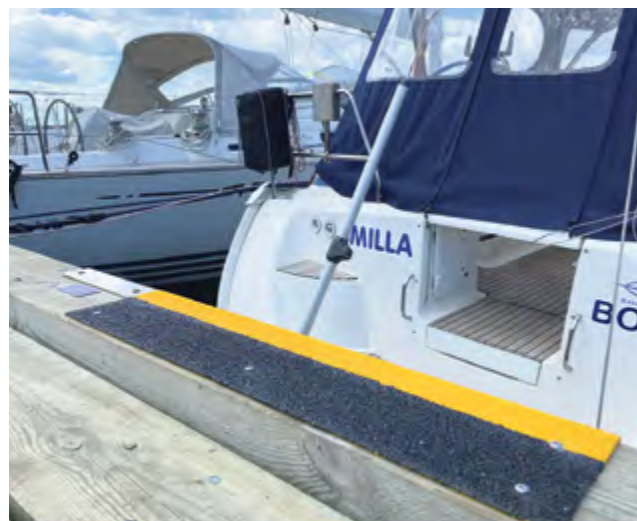
Skridsikring af den planke, man træder på, når man skal til og fra borde.
