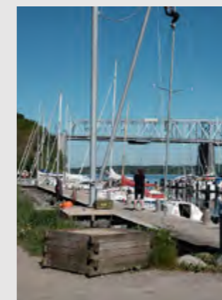
Udsigt til den gamle Lillebæltsbro, hvor du kan Bridgewalke.
