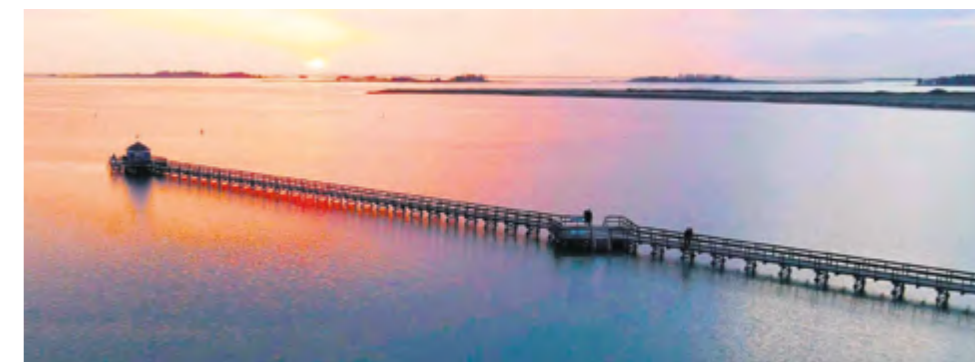
Badebroen, der er mere end 30 år gammel, har været igennem en gennemgribende renovering.
