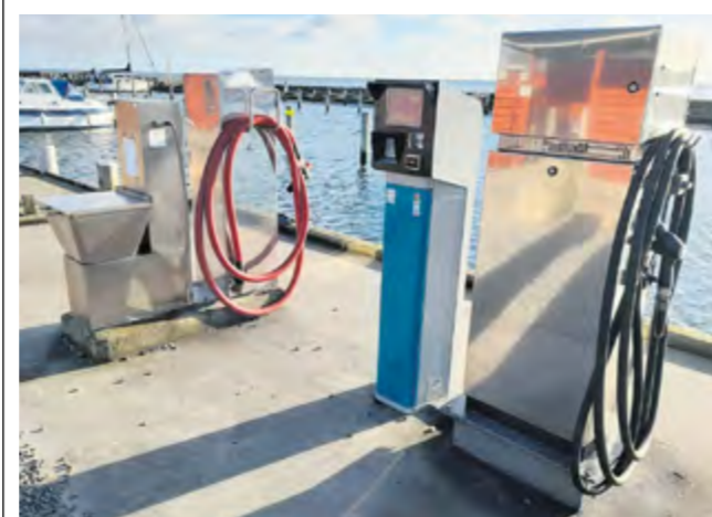
Det nye tømningssanlæg og dieselstanderen på Øster Hurup Havn.
