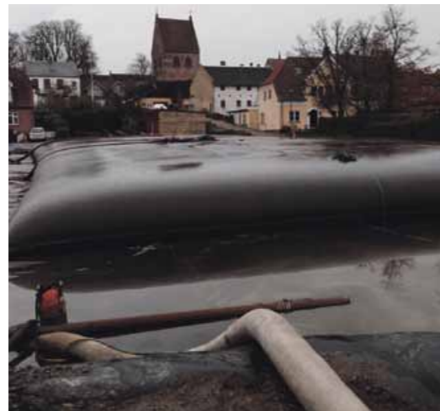
Geotubes på Stubbekøbing Havn
