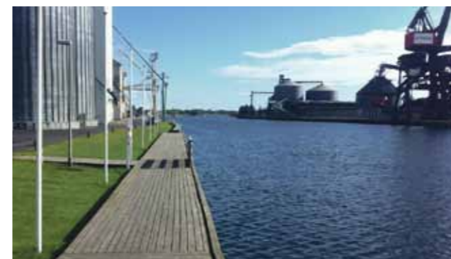
Gennemgang af brokonstruktion fra landsiden
