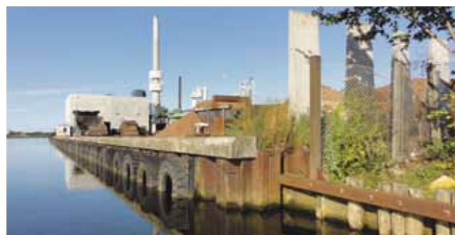
Gennemgang af kajstrækninger fra vandsiden
