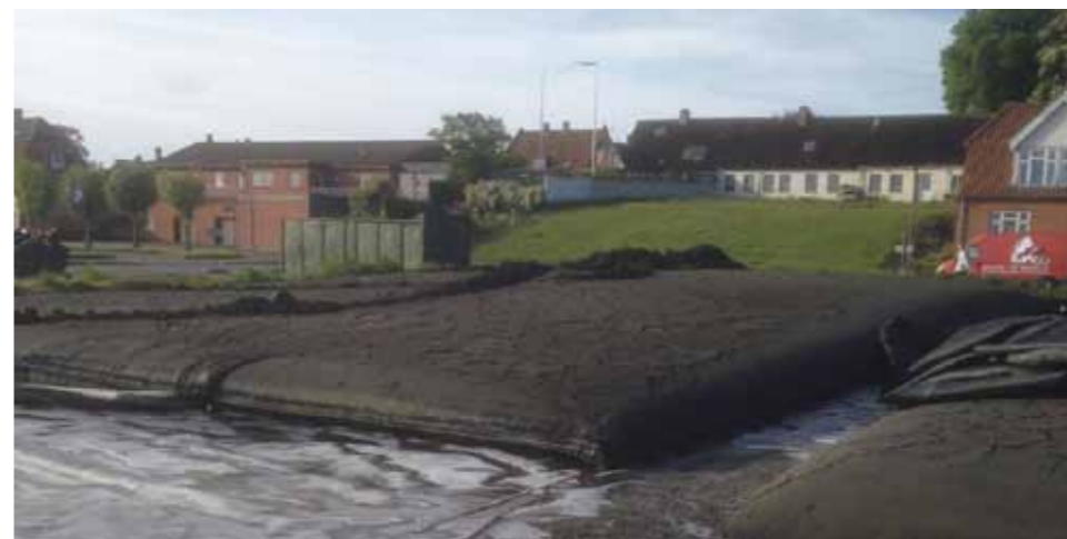
Tørret havnesediment klar til deponering
