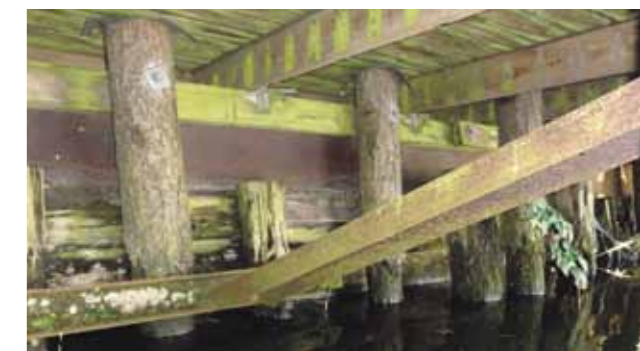
Gennemgang af brokonstruktion fra vandsiden.
