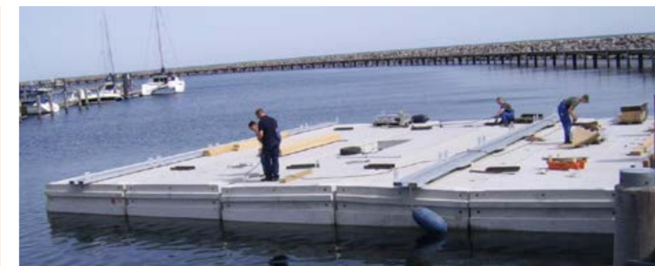
Pontech bistår med vægtberegning og projektering. Pontonerne produceres på egen fabrik i enten Sverige eller Tyskland. Her sammenkøbes og forankres de flydende platforme.
