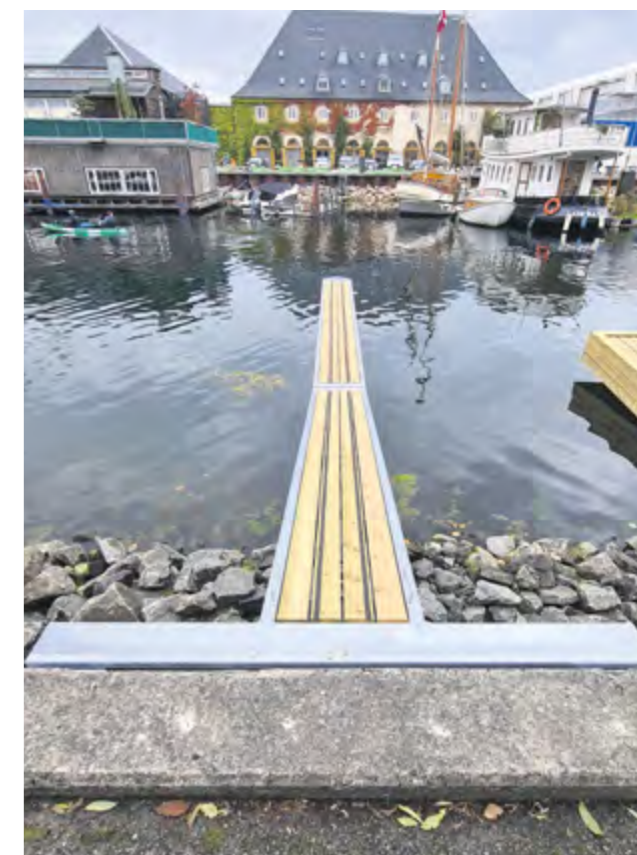
Hvor en havn normalt ikke kan udnytte kajlægen med stensætning yderst, giver de nye T-bomme ekstra pladser. Her er det i Christianshavns Kanal. Fotos: NBC Marine.
