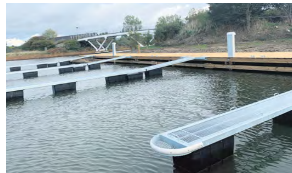
I Brøndby Havn er T-bommene monteret på en almindelig træbro. Agterpælene er ikke nødvendige og størrelsen på pladserne derfor mere fleksible. Bommene er 12 m lange, og skibene ligger langskibs.
