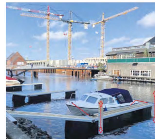
På fotoet fra Kalvebod brygge ses hvordan båden kan krydsfortøjes til bommen. Uden fortojning i land følger båden med vandstanden.
