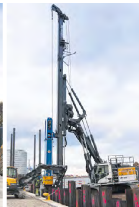
De i alt 790 spuns skal tilsammen udgøre en 1 km lang spunsvæg foran den eksisterende gamle Langelinie kaj. Når spunsplælene er rammet ned, fastgøres væggen med flere end 400 borede jordankre, der skal sikre, at kajen kan holde mange år endnu. . Fotos: Hercules Fundering.
