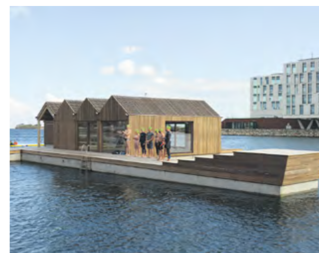
SF Pontona har leveret platformen til det flydende aktivitetshus ved Sandkajen i Nordhavnen. Foto SF Pontona.
