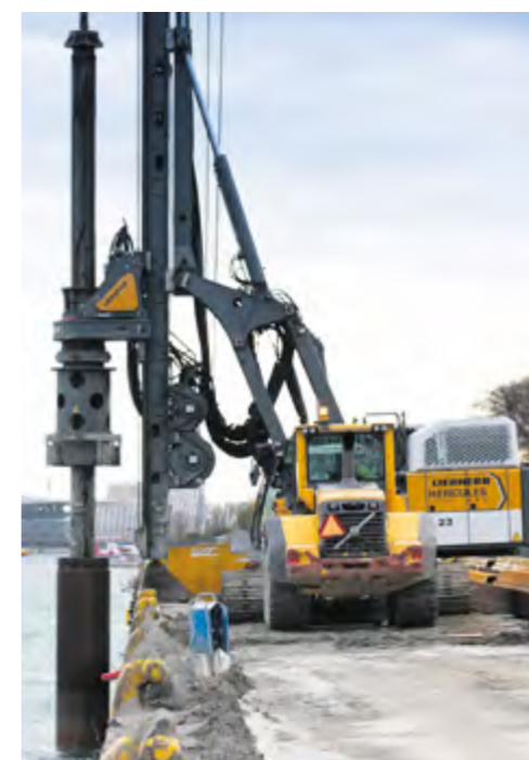
De i alt 790 spuns skal tilsammen udgøre en 1 km lang spunsvæg foran den eksisterende gamle Langelinie kaj. Når spunsplælene er rammet ned, fastgøres væggen med flere end 400 borede jordankre, der skal sikre, at kajen kan holde mange år endnu. . Fotos: Hercules Fundering.
