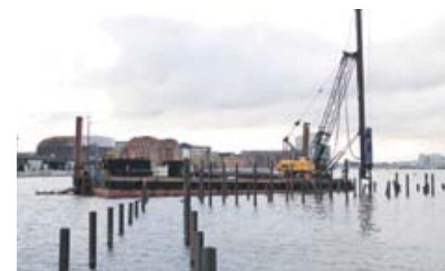
284 pæle danner fundament for den 4.000 m 2 store Kalvebod Bølge
