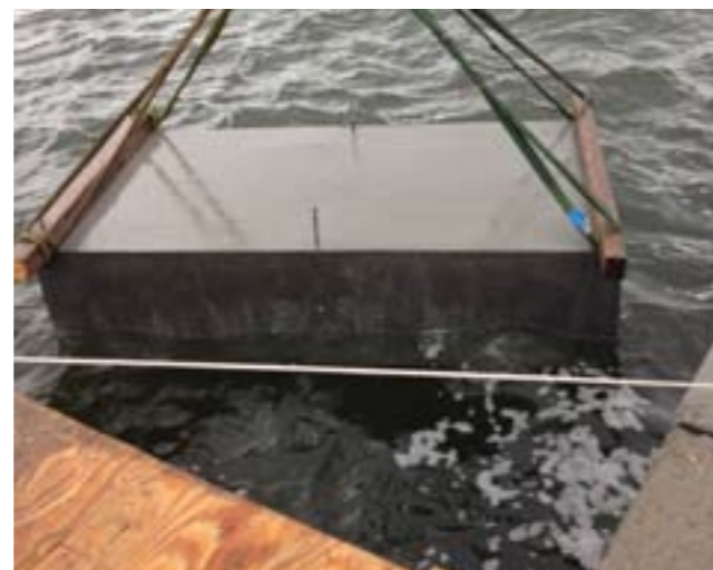
Et af ponton elementerne søsættes. Der blev bygget 180 ialt. Foto: Tommy Jensen, Handbjerg
