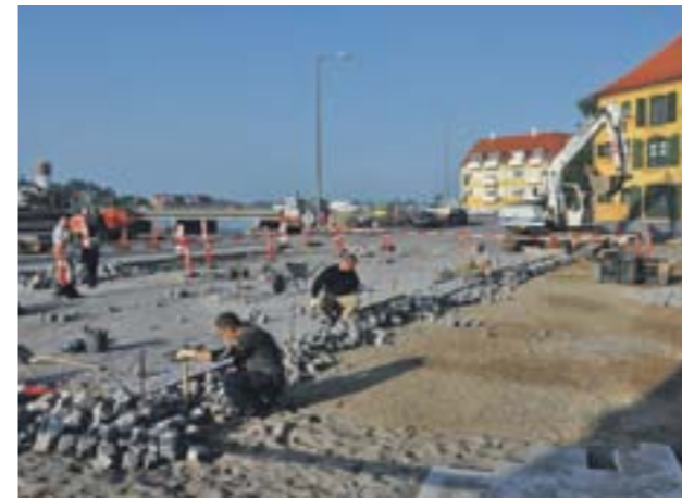
5.000 m 2 granitstensbelægning er en sjælden stor opgave.
