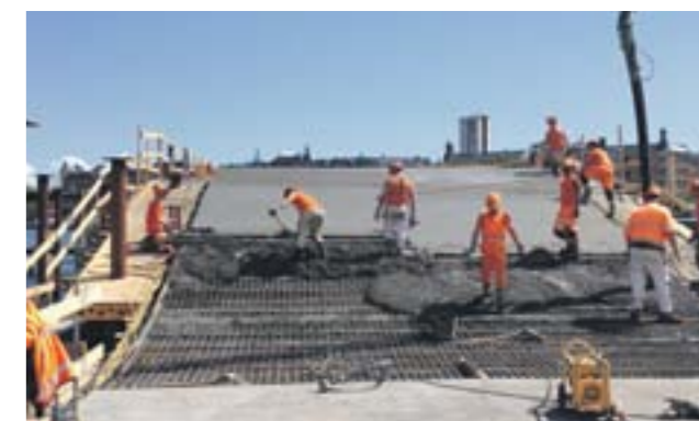
Den 400 m 2 store betondæk støbes på stedet.
