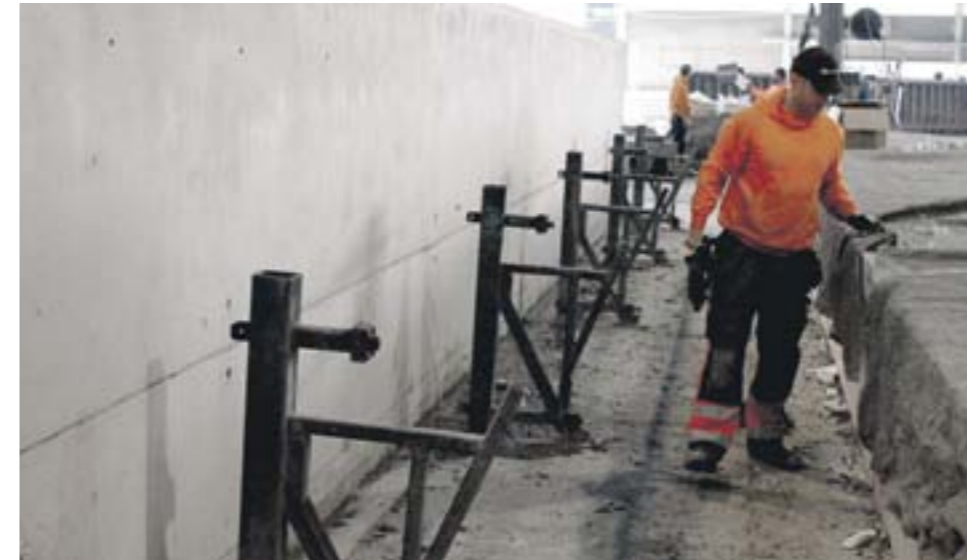
Et glimt fra fabrikken, hvor Pontona støber sine elementer. Fotos: SF Pontona.
