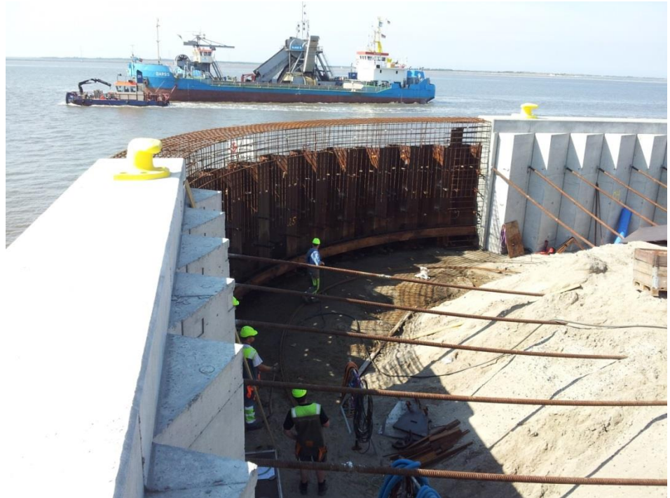
Leokaj - Geminikaj. Beton hammer støbt med friktions-fortanding.
