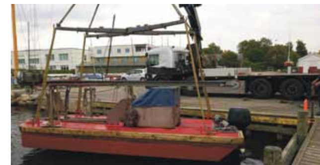
Det mobile ramslag sættes i vandet ved hjælp af kranen på lastbilen. Fotos: Bang-Co.
