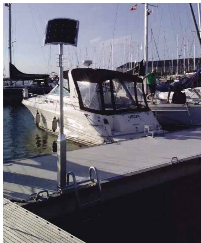
Stander med solceller og backup oven for redningsstigen. Fotos: Sea-Safe.
