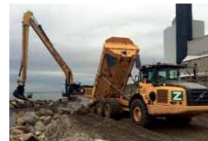
Renovering af Rungsted Havn
