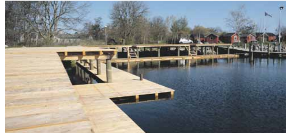
Broerne står færdige - klar til digehusene.
