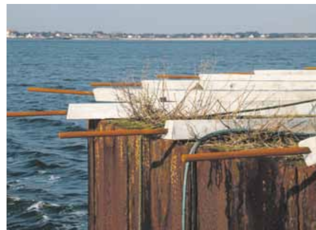
Anoder på et molehoved. Foto: E.A. Dykker Service
