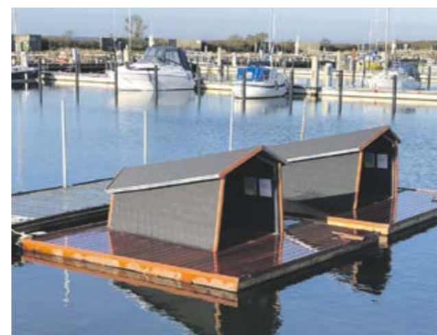
De to flydende sheltere i Bogense Marina er bygget på polystyren og kan bære op til tre ton. Fotos: Bogense Havn og Marina
