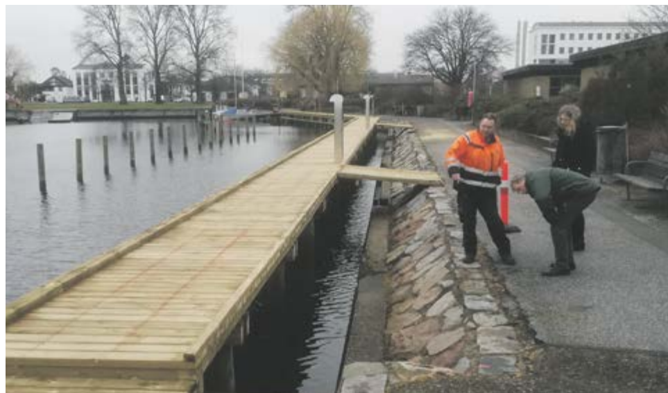
Marineimprægneret træ er bl.a. anvendt til broer og pæle i Kastrup Gl. Lystbådehavn Foto: NSH Nordic
