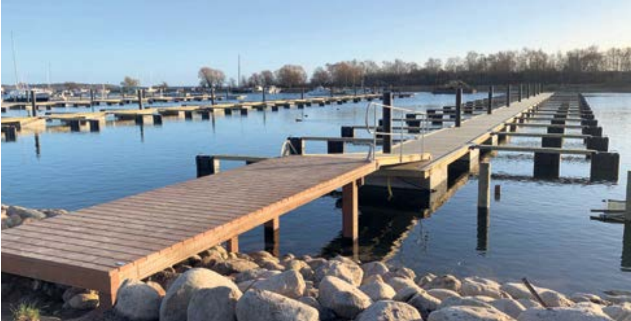
Nye flydebroer med I-bomme sparer plads i bassinet og giver plads til en ekstra bro. Fotos: NBC Marine.
