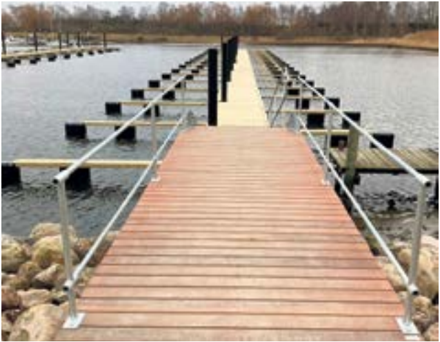
Landgangen over stensætningen med gelænder.
