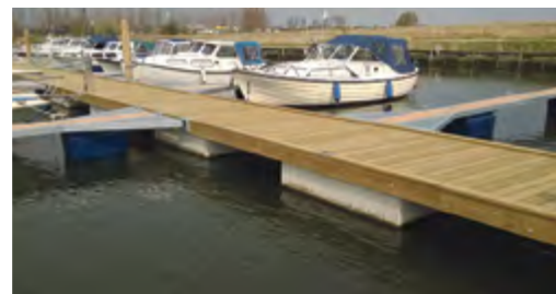
Flydebroer med del-pontoner og Y-bomme. Kan leveres træbeklædt.
