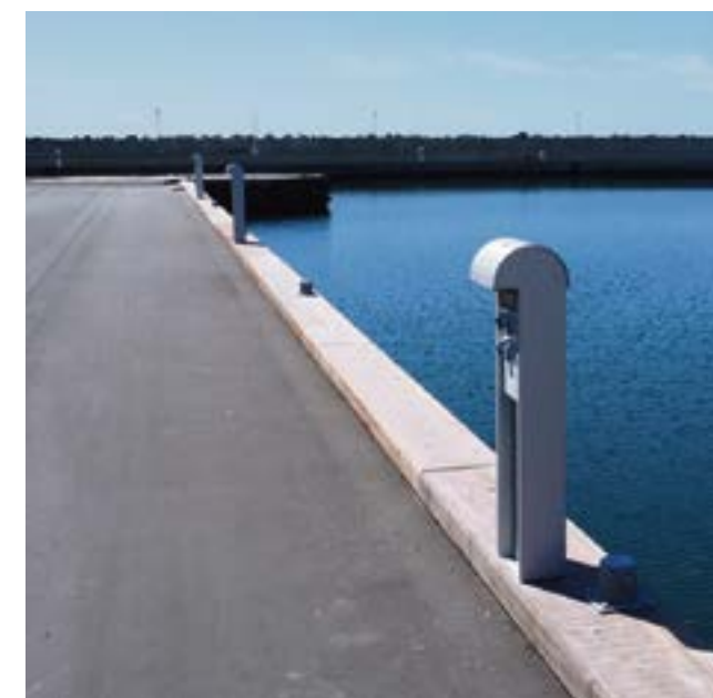
Nye asfaltarbejder er en del af renoveringen af Sejerø Havn. Fotos Arkil Vandbygning.
