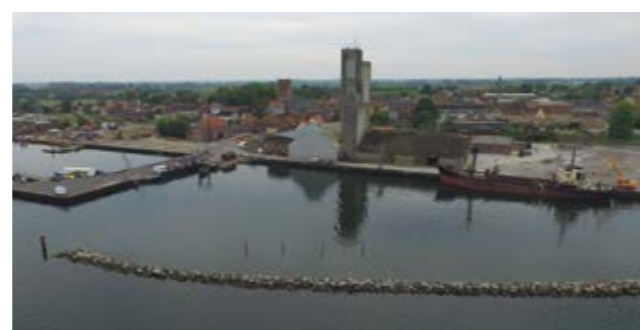
Erhvervshavnen i Stubbekøbing er præget af de høje siloer, som nu skal fjernes. Lokalplanen giver på sigt mulighed for boligbyggeri i området. Foto: MarinaGuide.dk
