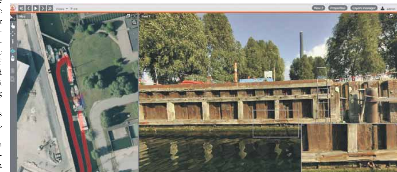
Internetbaseret viewer (til venstre oversigtsfoto (luftfoto) med undersøgt strækning og position for street view foto til højre. Mulighed for at zoom for at kunne studere evt. skade på bolværket.
