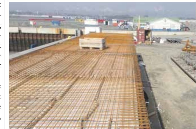
Pontonerne støbes på stedet og søsaettes med kran. Foto: MEC Marine
