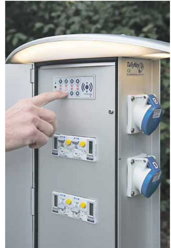
Betjeningspanelet i elstanderen, hvor brugeren vælger udtag. Resten foregår via en app, hvor brugeren kan styre el-forbruget.
