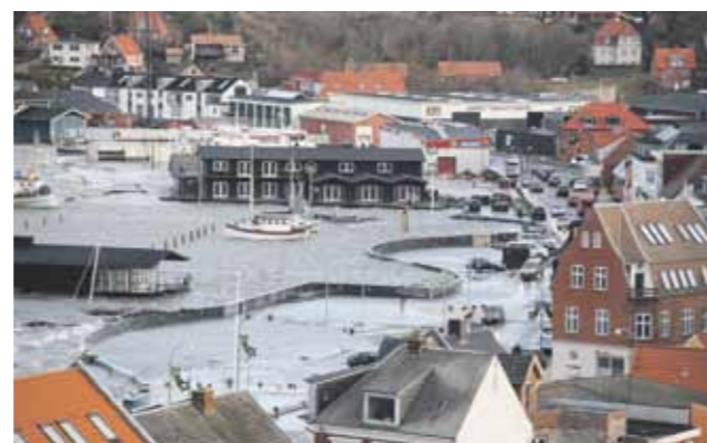
Lemvig Havn under "Bodil" 2012, hvor højvandet presser på den buede mur. Hasløv & Kjærsgaard var arkitekter på 1. etape af højt vandssikringen. Foto: Mads Krabbe.
