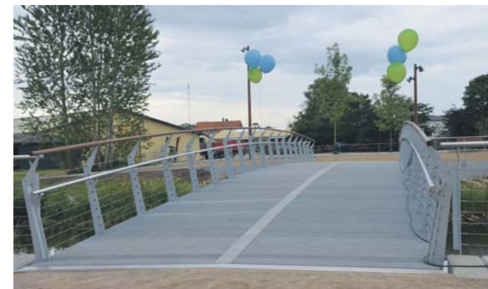
Bro bygget af stål og genbrugsplast hen over Skive Å. Fotos: By Bang.
