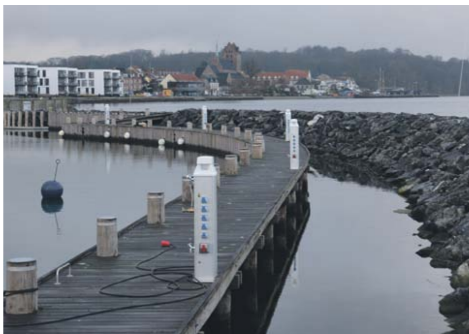
Nyhavn 2 er bygget med bådebroer i ædeltræ og moler af sort granit. Heller ikke strømstandere er der sparet på: Her er flere strømudtag end bådpladser.
