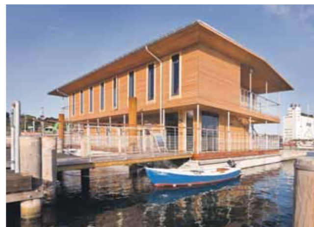
Havnekontor og servicebygningen i Svendborg er et velkendt eksempel på en flydende bygning. Foto: Afloat.online
