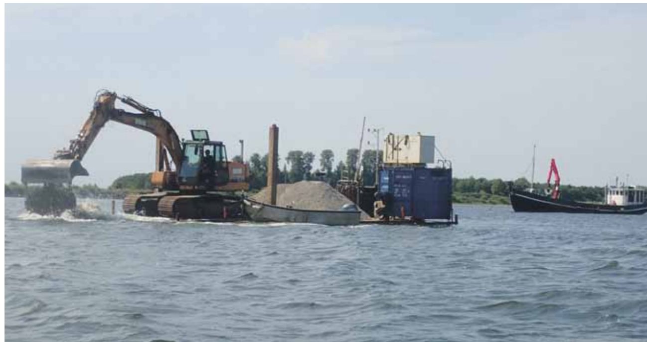
I stor-skala-forsøget på Odense Fjord dækkes bunden med et lag sand ved hjælp af en gravemaskine.
