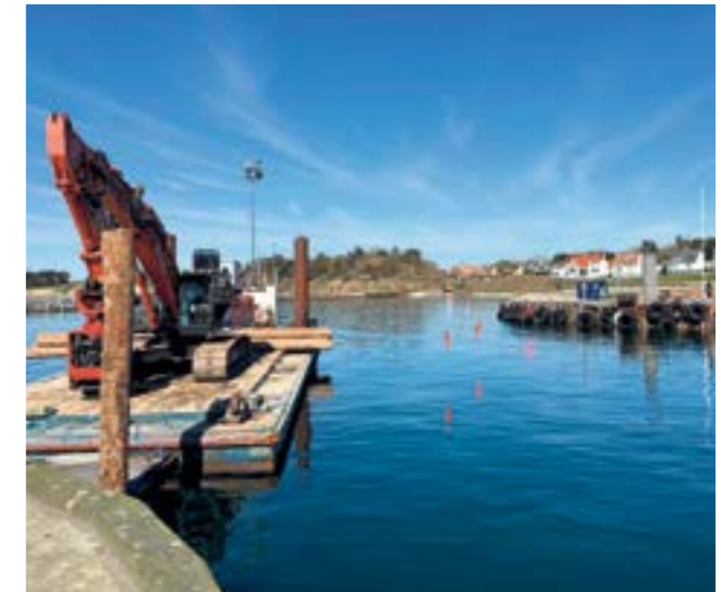
Munck Havne & Anlæg er igang med at bygge to nye bølgebrydere i Kolby Kås Havn. Foto: Kaia Bertelsen.
